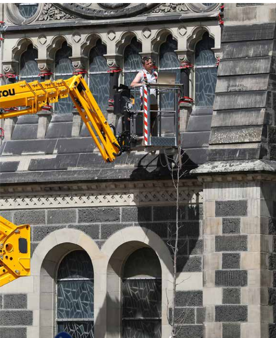
Die Fassade ist mit Hunderten roter Spanngurte gesichert.
